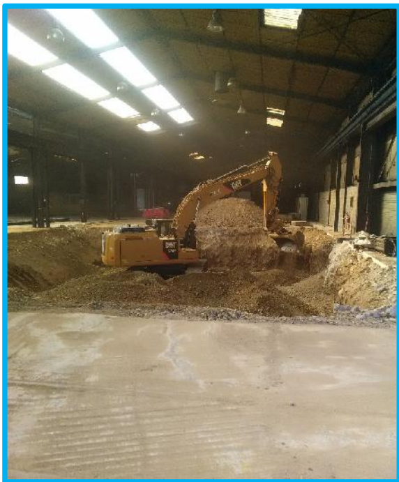
Suite du remblaiement + compactage passe 1 et 2
