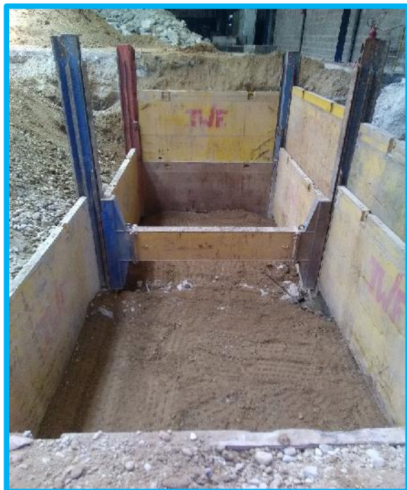
Mise en place des bétons + matériaux d'apport et compactage
