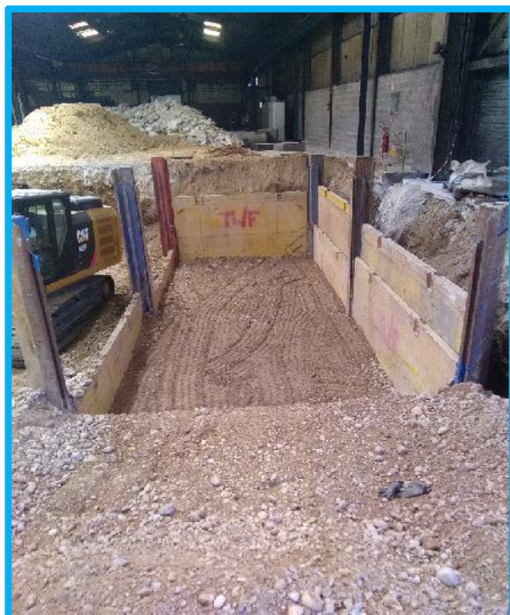
Remblaiement de la passe 1 avec matériaux d'apport + compactage
