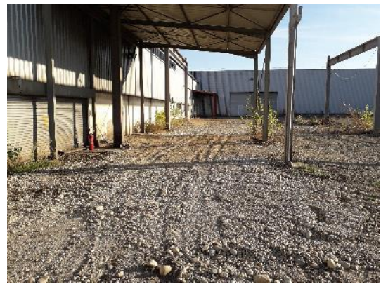
Vue sur la zone extérieure après remblaiement
