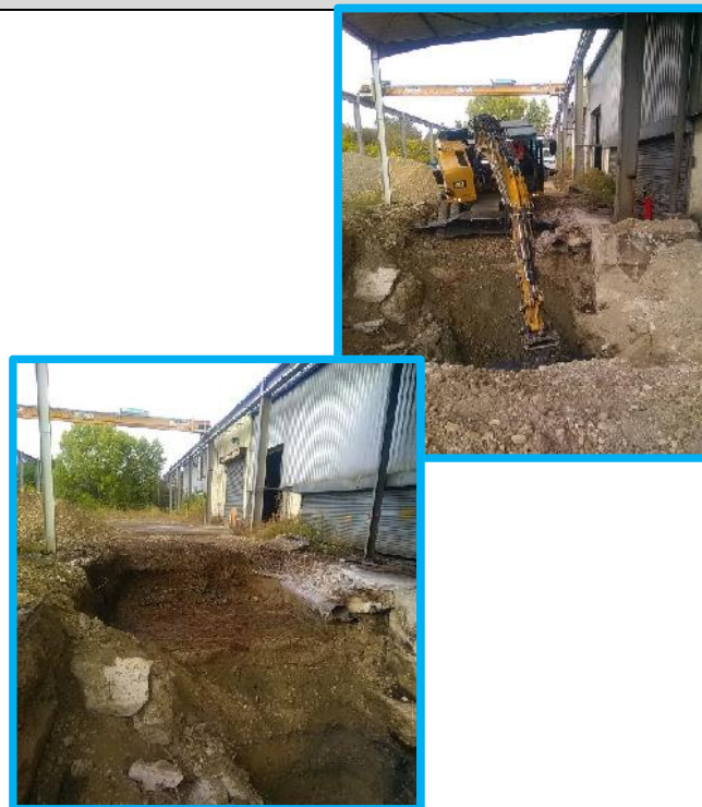
Demarrages des extensions exterieures
