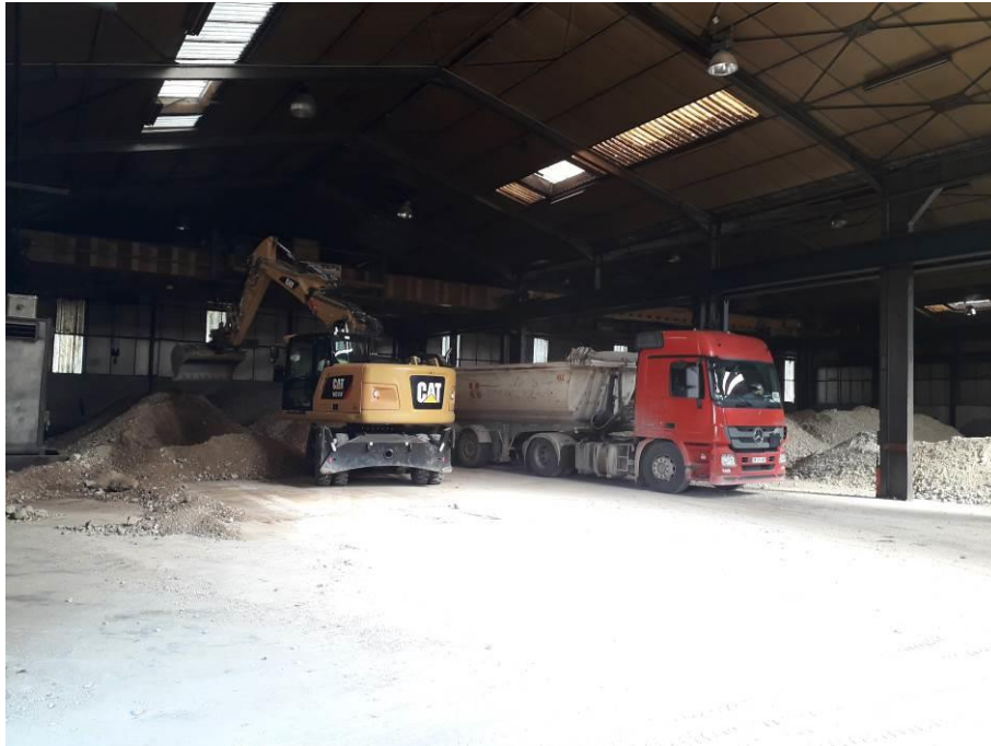
Evacuation des tas de terres stockés à l'intérieur du bâtiment
