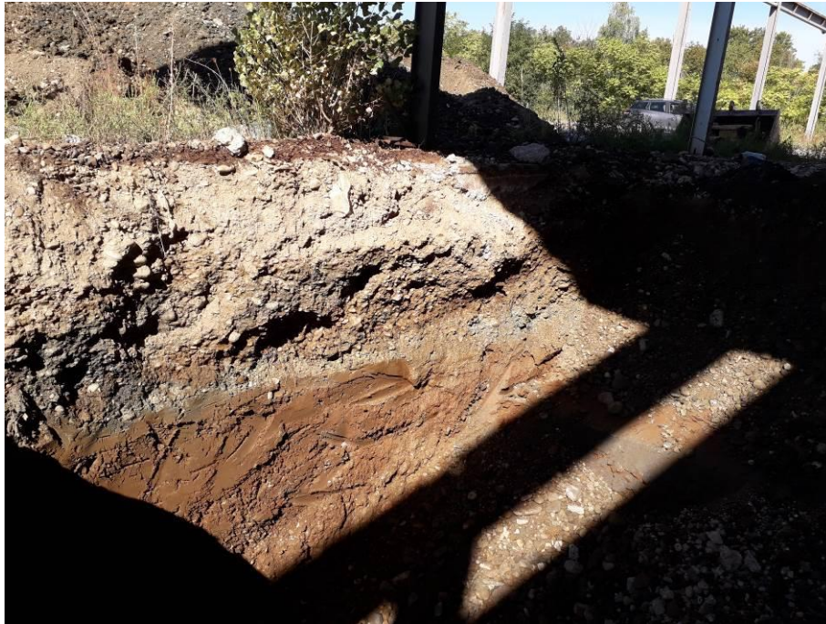
Flanc de fouille de la passe extérieure – côté ouest (à environ 7 m du mur du bâtiment)
