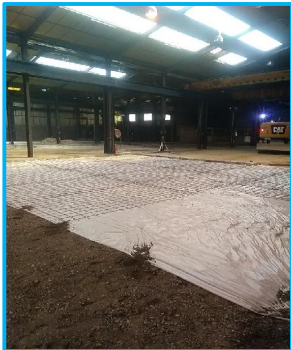
Mise en place de la zone intérieure avant refecton des dallages
