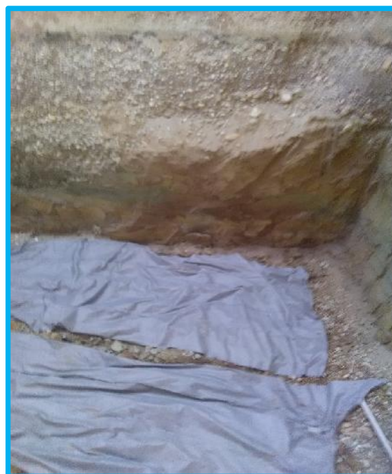
Mise en place du geotextile en fond de fouille
