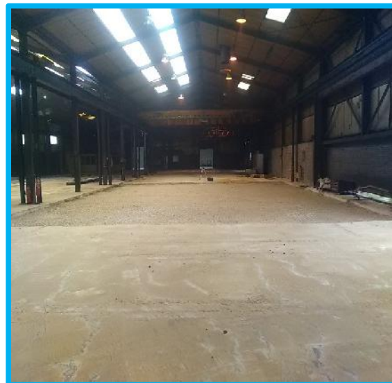
Reglage de zone interieure avant refecton du dallage
