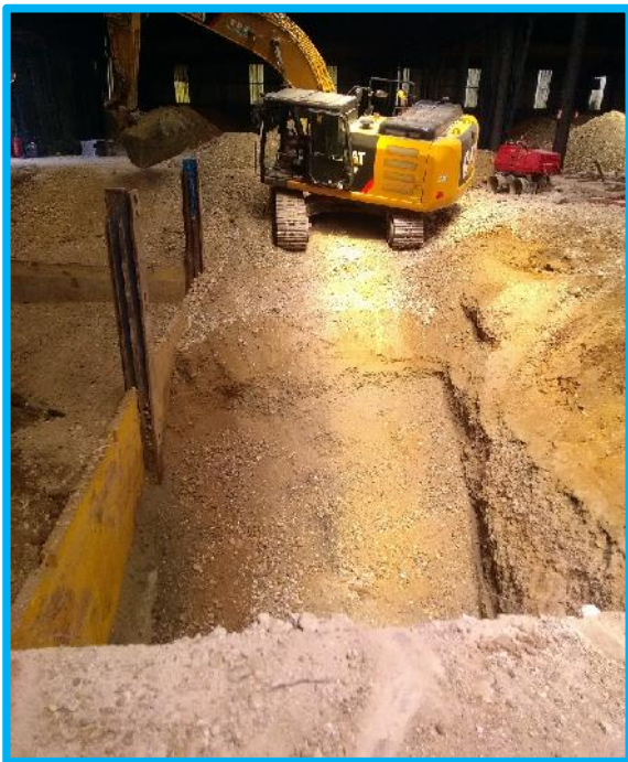
Suite du terrassement passe 2
