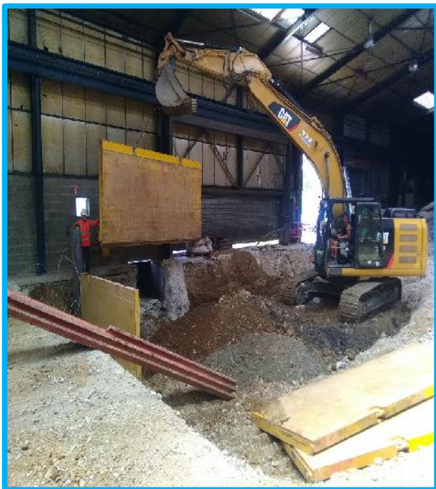
Démarrage et mise en place du blindage passe 1
