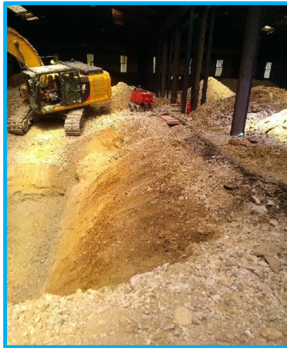
Talutage du terrassement
