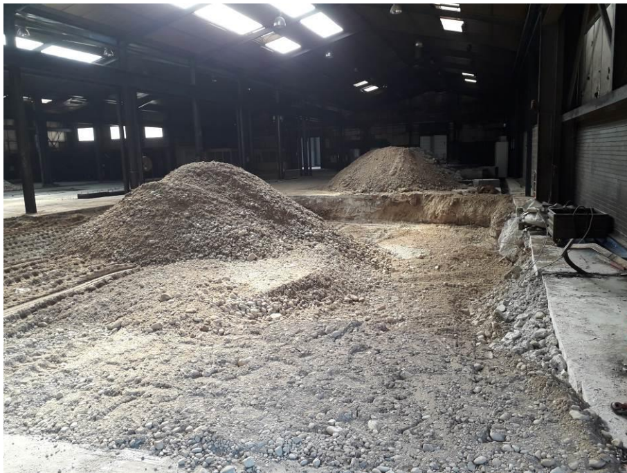
Remblaiement de la passe intérieure en cours avec matériaux d'apport
