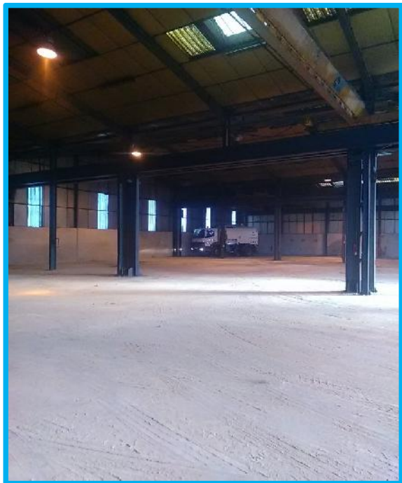
Balayage du hangar intérieur
