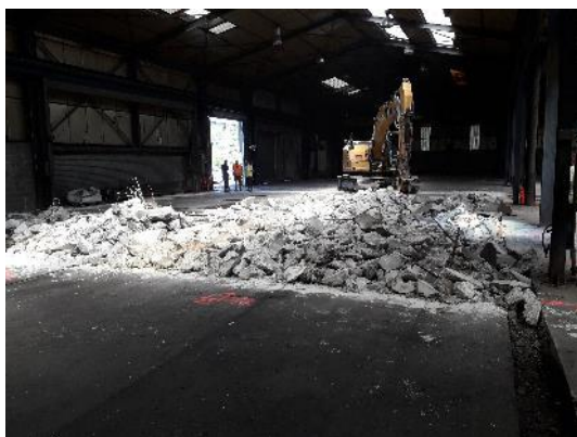
Démolition de la dalle
