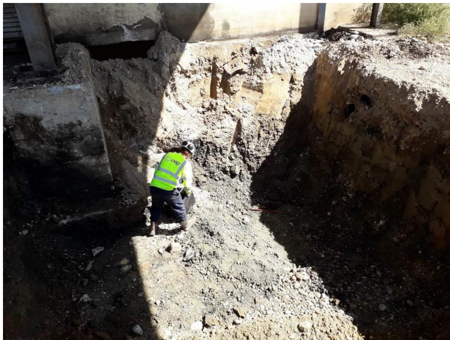
Vue depuis le flanc est de la fouille – prélèvement en cours dans la zone impactée proche du mur du bâtiment
