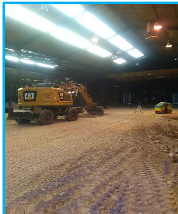
Reglage de zone interieure avant refecton du dallage
