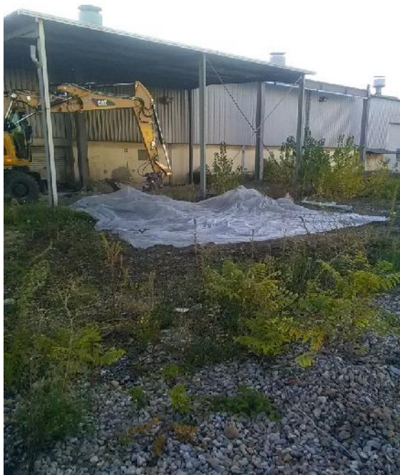
Mise en place d'une zone étanche
