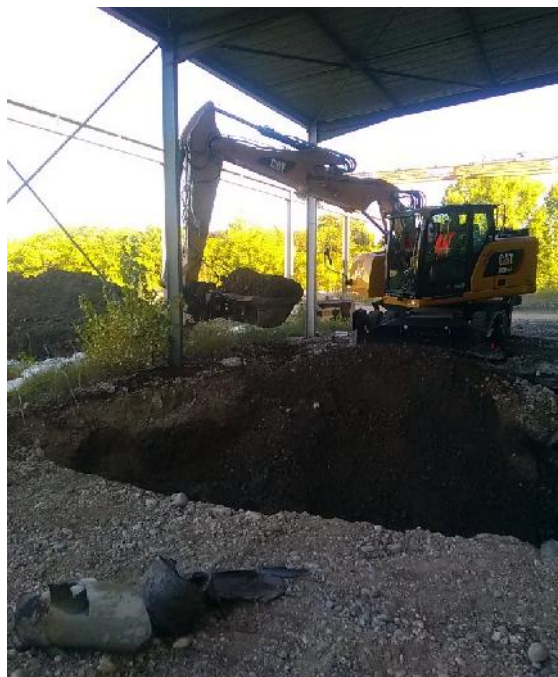
Terrassement de la zone extérieure (7m*6m)
