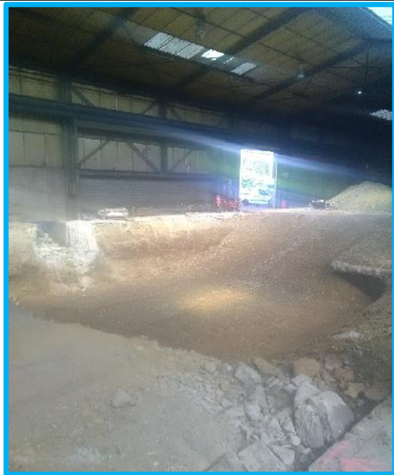
Suite du remblaiement + compactage passe 1 et 2
