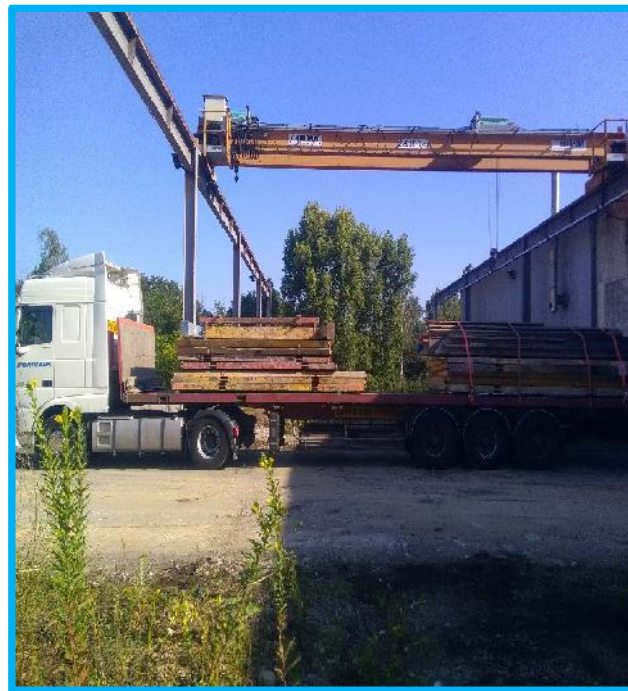
Chargement et repli du blindage
