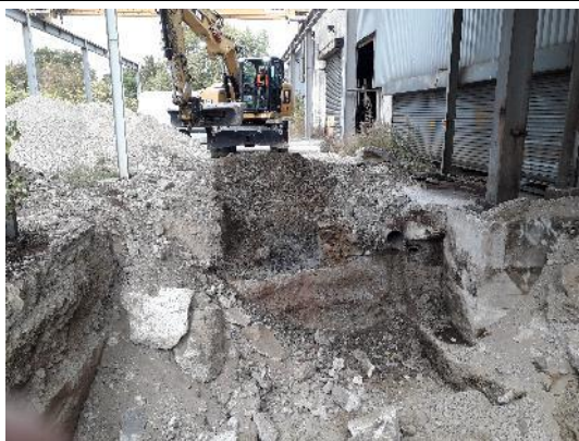
Excavation de la fouille avec indices organoleptiques de pollution
