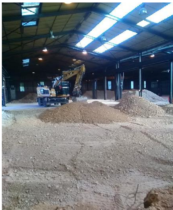
Suite du remblaiement et du compactage de la zone intérieure
