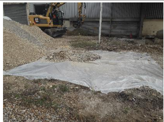
Stockage des terres sur film polyane
