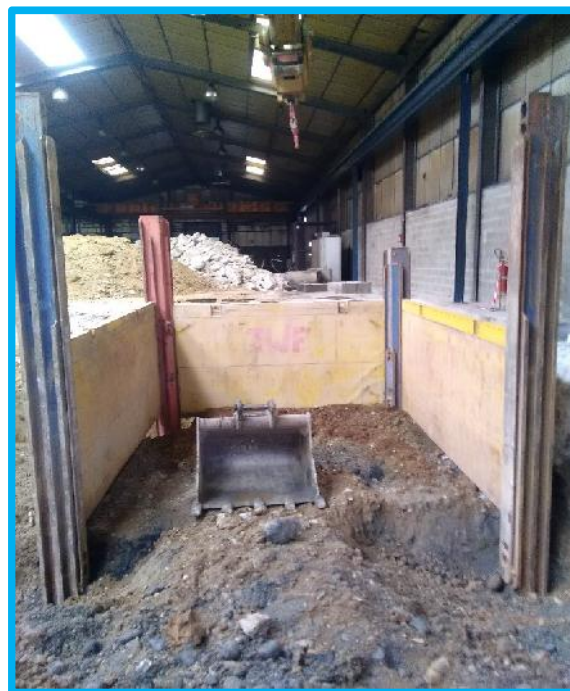
Démarrage et mise en place du blindage passe 1
