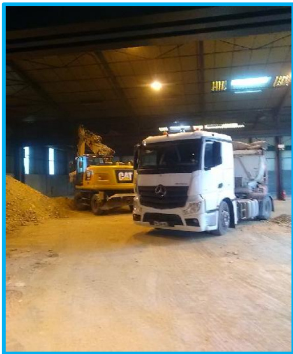
Chargement et évacuation des terres polluées de la zone intérieure
