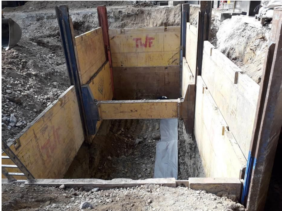
Passé 1 – photo prise pendant la mise en place du géotextile en fond de fouille
