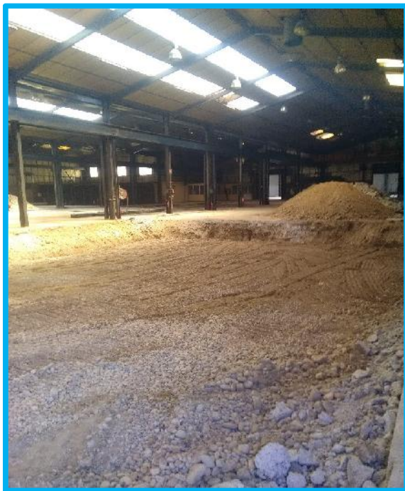
Suite du remblaiement + compactage passe 1 et 2
