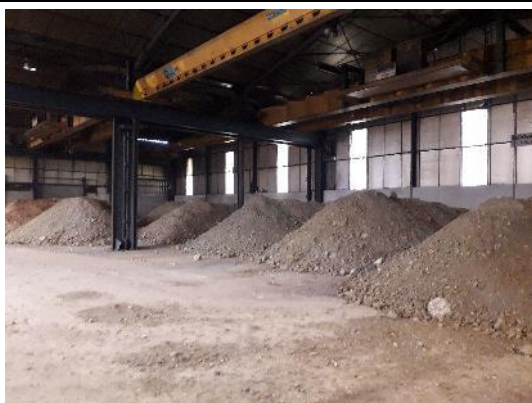
Stockage des terres en intérieur par lots de 50 m 3 environ
