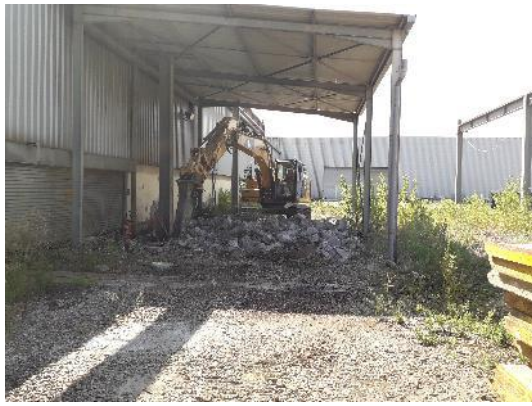
Démolition de la dalle en zone extérieure
