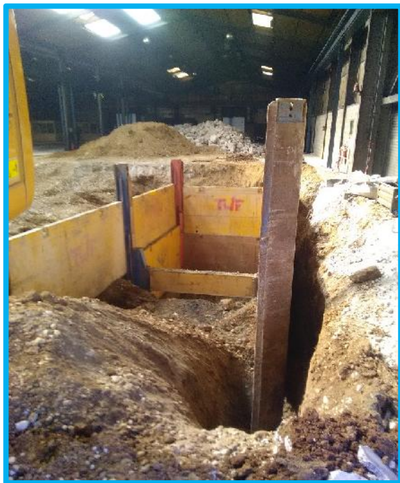
Suite des terrassement avec blindage de la passe 1
