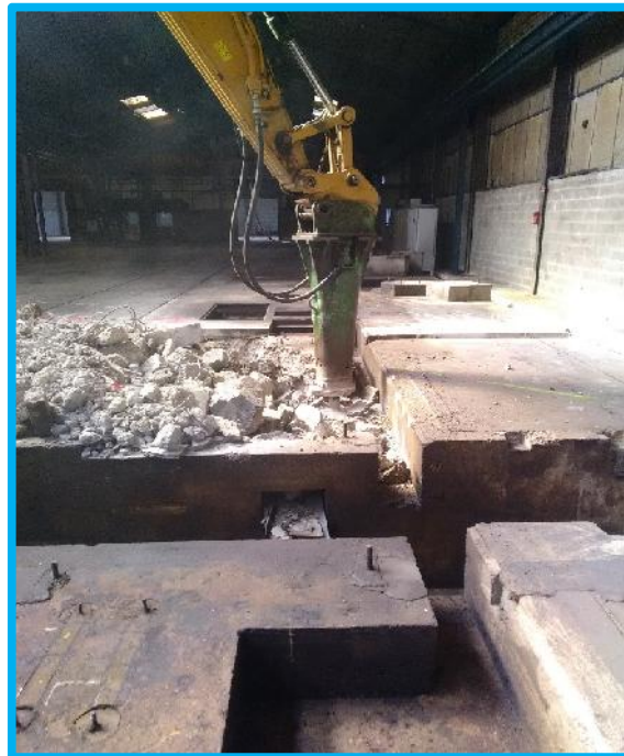
Piquage de la dalle au BRH
