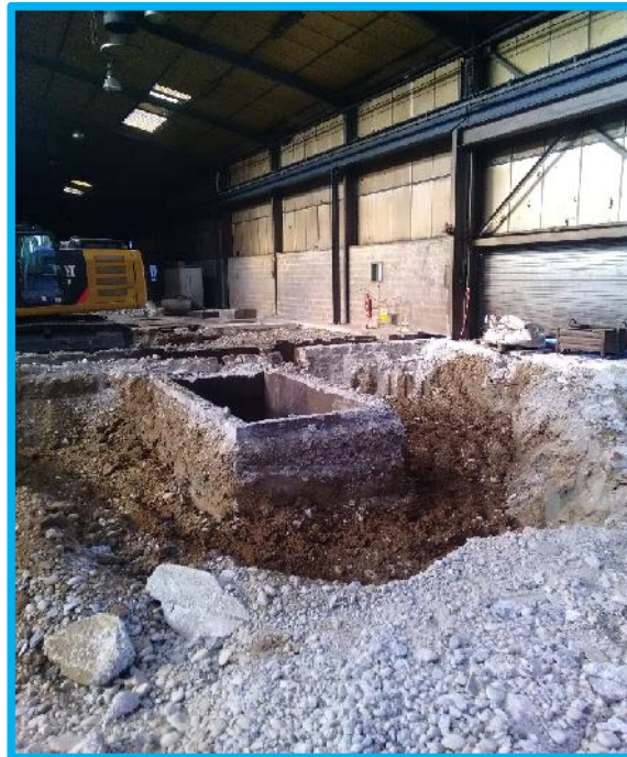
Décaissement des 1,5 m de déblais
