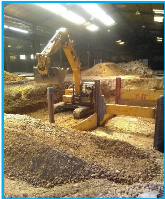
Démarrage du terrassement passe 2
