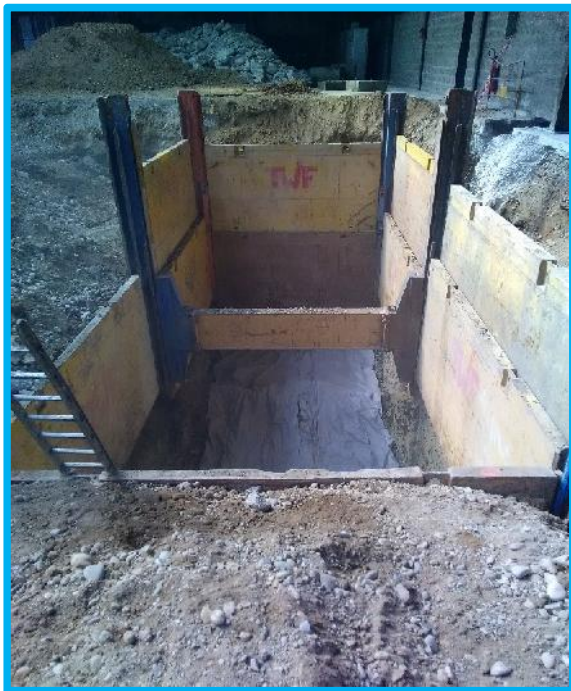
Mise en place du géotextile
