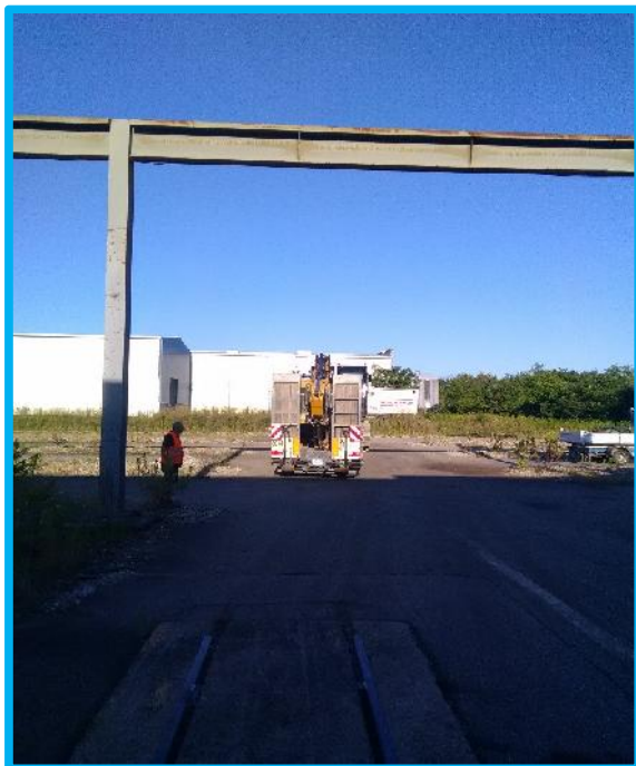
Livraison de la pelle mécanique
