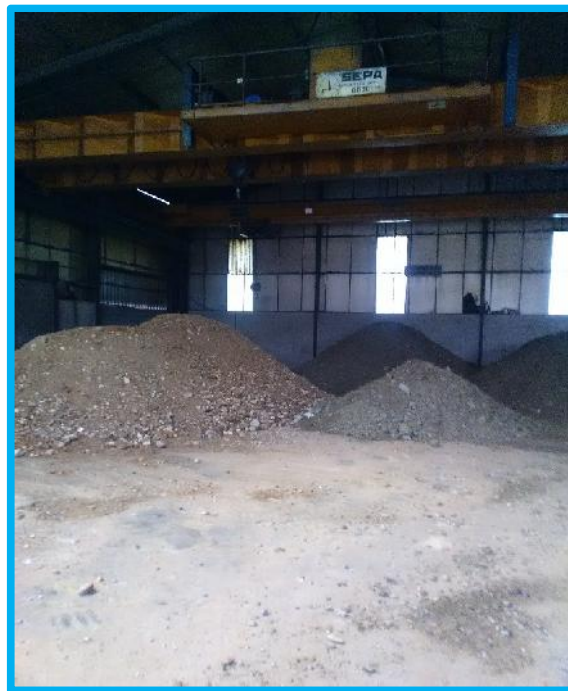
Transfert et stockage des terres en lot (5 lots)
