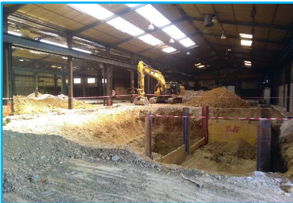
Balilage de la fouille
