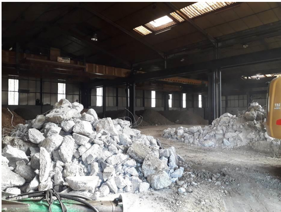
Stockage des bétons
