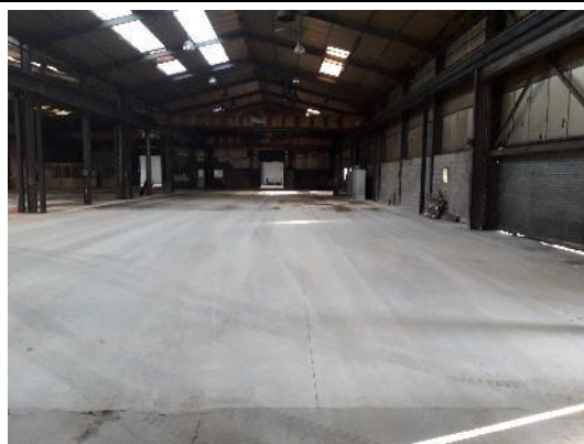
Dalle réfectionnée – réception des travaux
