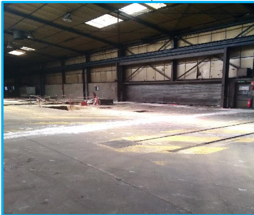
Démarrage des découpes de dalle
