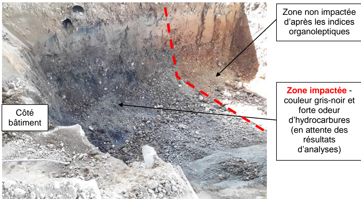
Vue depuis le nord-est de la fouille de la passe extérieure – nette distinction entre zone impactée (côté mur, convoyeur à copeaux) et non impactée.
