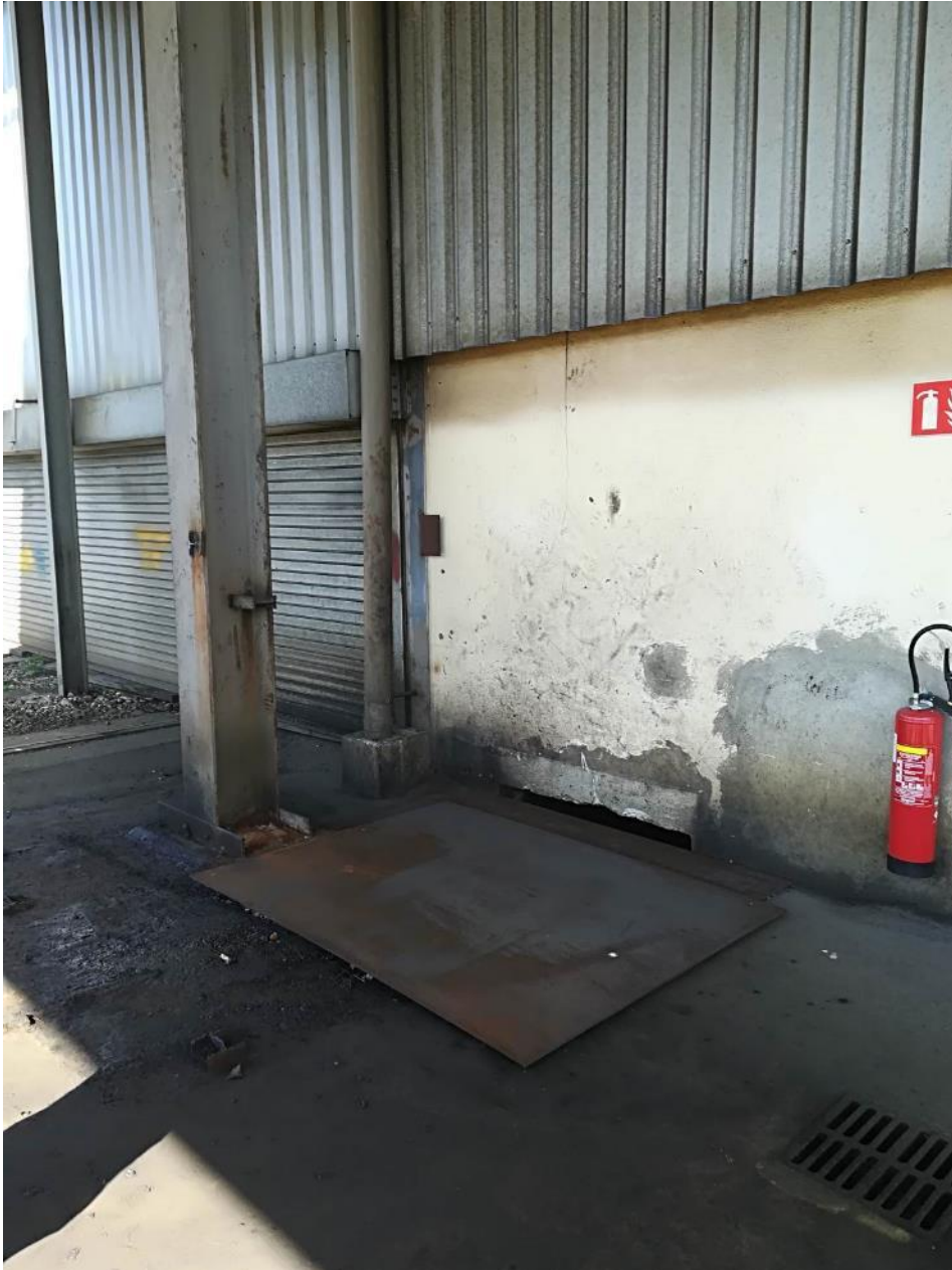
Ci-dessus : photo de l'ancienne zone des bennes à copeaux (extérieur), attenante au mur du hall. La sortie du convoyeur à copeaux se faisait sous la plaque métallique. (Avril 2018)
