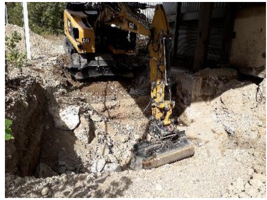
Excavation en zone extérieure
