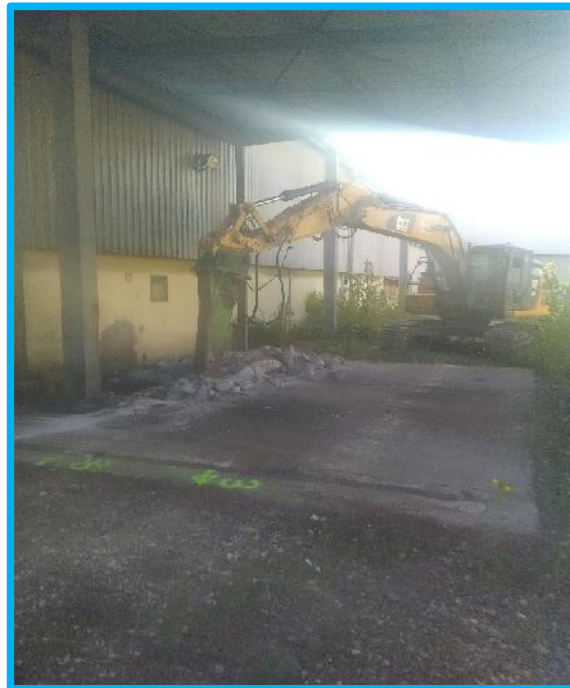
Piquage de la dalle extérieure au BRH
